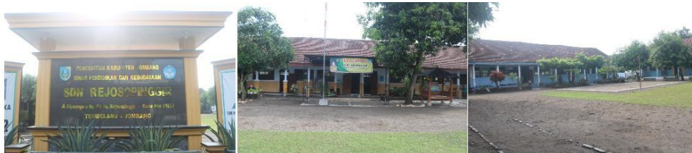
Gambar 1. Kondisi SDN Rejosopinggir
